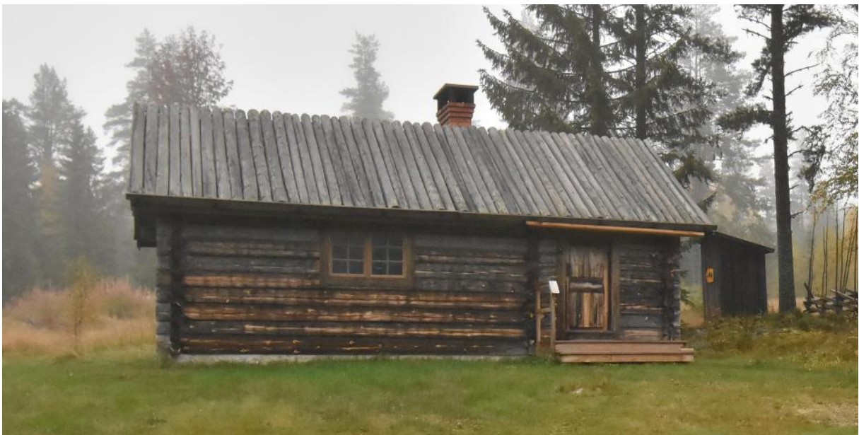
Sportstuga - Med modern standard på det mesta. De påminner främst om sätesstugorna om i sin planlösning och storlek, men både grunden och de nytillverkade (relativt sett) stockarna visar att de aldrig eller sällan har byggts av stockar från raserade fåbodhus. (Sälen)
